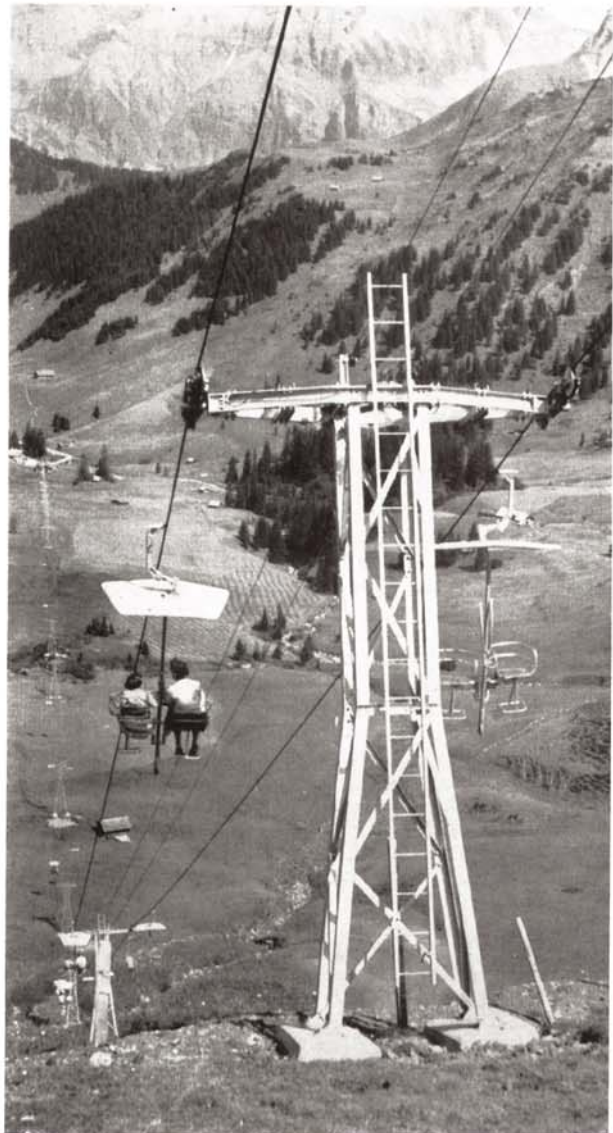
Neuartiger Doppelsessel. Die Sitze können nach hinten ineinander geschoben werden, sodaß die Fahrgäste beim Verlassen des Sessels nur auf die Füße zu treten brauchen, während die Sessel zwischen den beiden stillstehenden Fahrgästen mit verminderter Geschwindigkeit hindurch fahren
