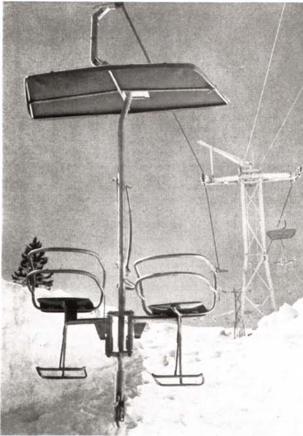
Neuartiger Doppelsessel. Die Sitze können nach hinten ineinander geschoben werden, sodaß die Fahrgäste beim Verlassen des Sessels nur auf die Füße zu treten brauchen, während die Sessel zwischen den beiden stillstehenden Fahrgästen mit verminderter Geschwindigkeit hindurch fahren
